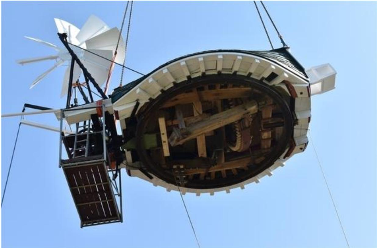
*Kein unbekanntes Flugobjekt: Der 160-Tonnen-Kran der Stader Firma Buchen hebt die etwa 13 Tonnen schwere Haube der 1848/1849 errichteten Windmühle „Venti Amica“ in Twielenfleth in die Luft.*
