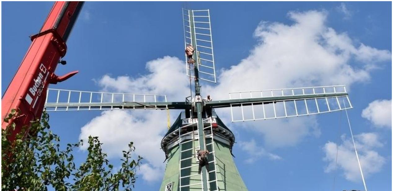
*Kurz nach 16 Uhr ist das Flügelkreuz montiert (Durchmesser: 21,40 Meter). Der ortsbildprägende Galerieholländer sieht wieder schick aus. Heute sollen die verstellbaren Jalousieklappen montiert werden.*
