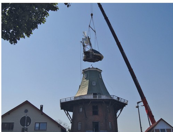
...folgte nach dem Einsetzen des Kammrads das Aufsetzen der reparierten Mühlenkappe...
