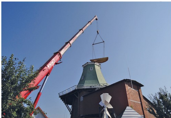
Nachdem zuerst das Notdach entfernt wurde...
